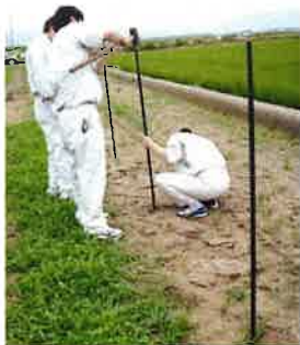
①ハンマー等で支柱を打ち込み
