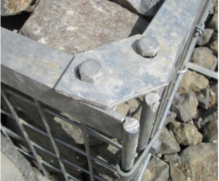
C: 角継ぎプレート取付部
